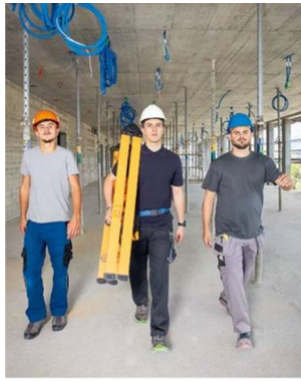
10 regole vitali per i tecnici della costruzione
